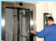
Ремонт или замена лифтового оборудования, ремонт лифтовых шахт
