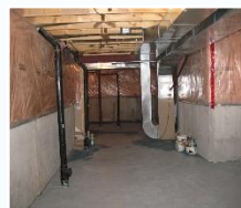
Ремонт подвальных помещений, относящихся к общему имуществу в многоквартирном доме
