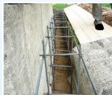
Ремонт фундамента многоквартирного дома
