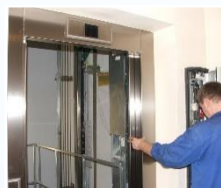
Ремонт или замена лифтового оборудования, признанного непригодным для эксплуатации, ремонт лифтовых шахт
