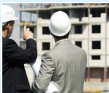
Осуществление строительного контроля*
