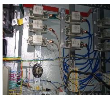
Ремонт внутридомовых инженерных систем электро-, тепло-, газо-, водоснабжения, водоотведения
